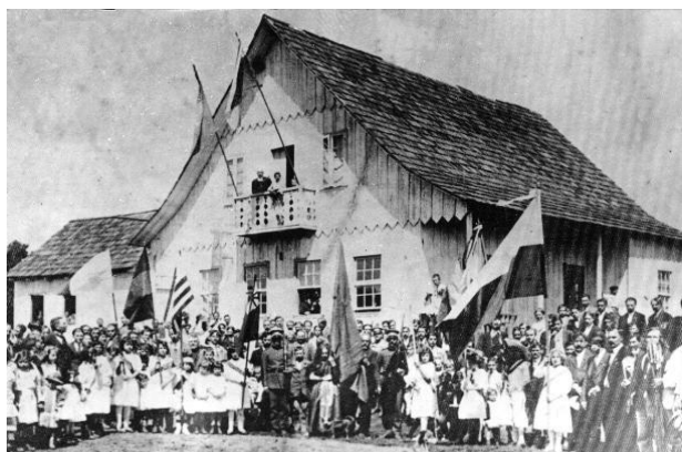
Figura 3- Prefeitura Municipal de Irati, anos 20, localizada a Rua 15 de Julho
